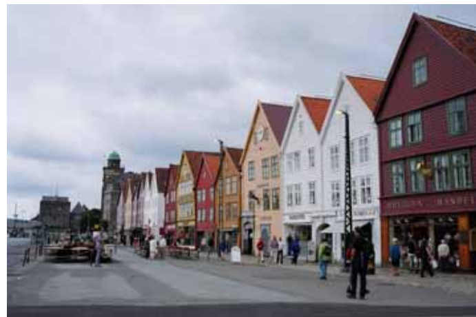
■ 列入世界遺產的木造房屋
