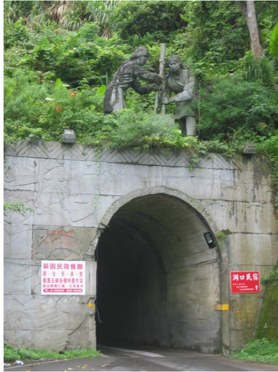
桃山隧道，只容一部車通過，車燈必備（借用網路上的照片）
